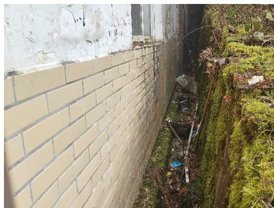
图 2.1-4 场地东侧现有排水沟和挡土墙
