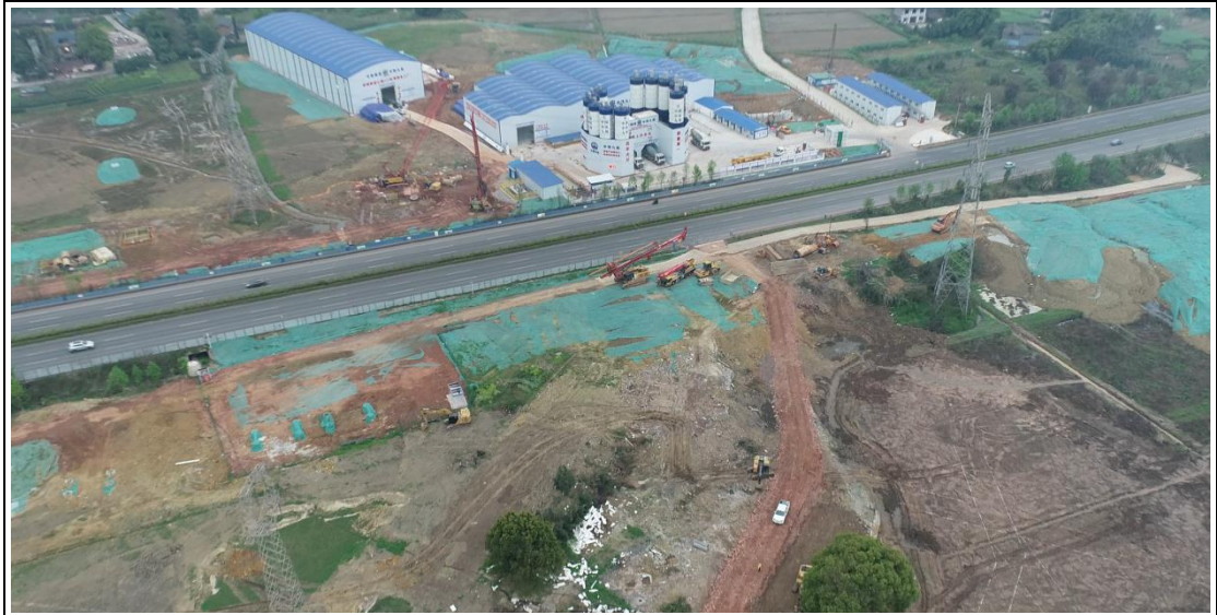
综合利用项目施工项目部照片
