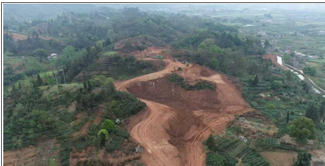
综合利用项目施工现场照片
